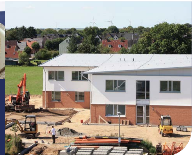
Hier entsteht das Verwaltungsgebäude (Ao1)
